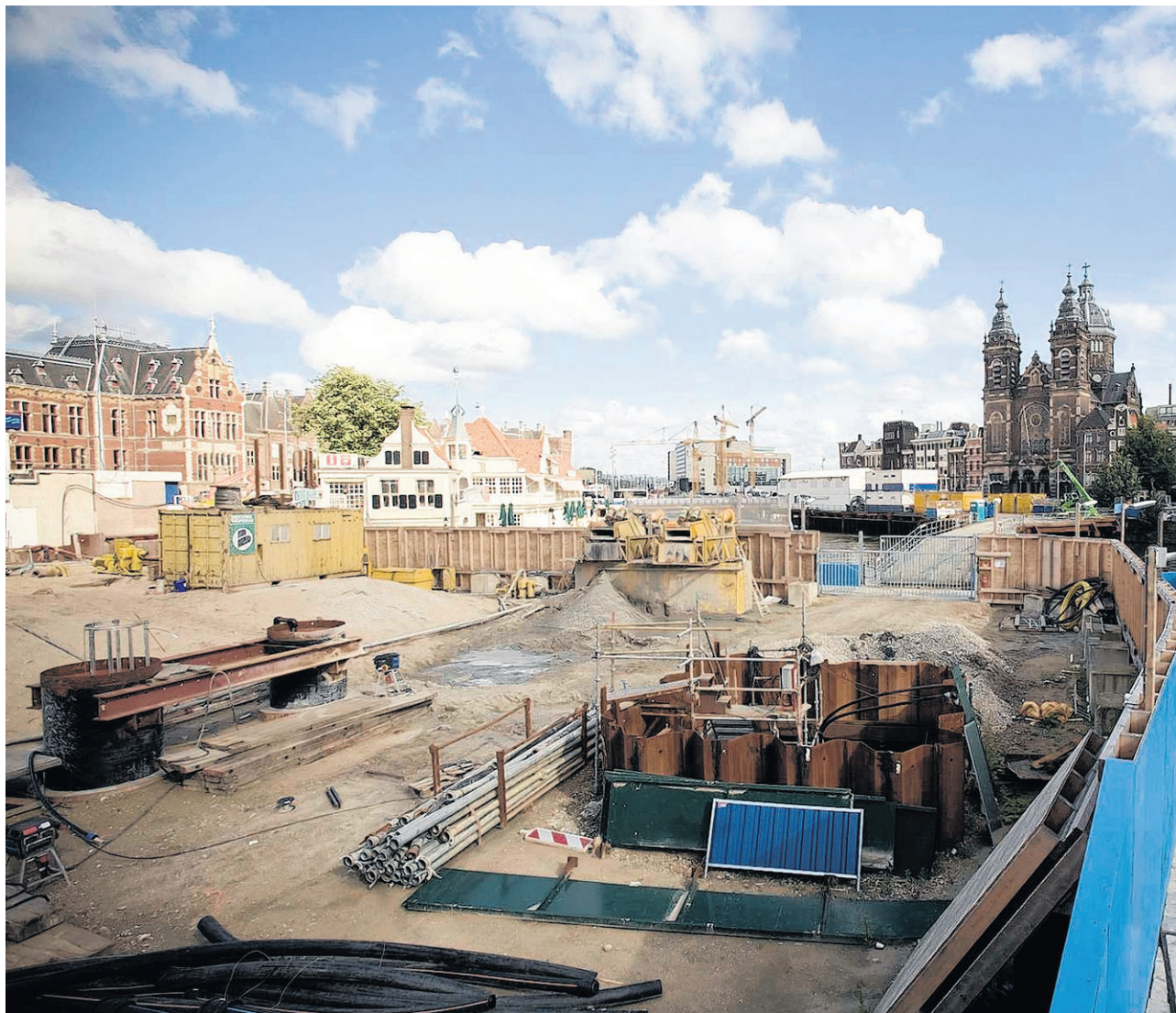
Werkzaamheden aan de Noord/Zuidlijn bij het Centraal Station.
